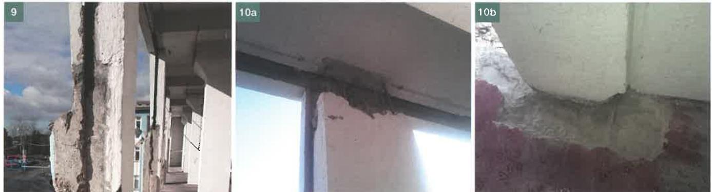
Prefabrikované dílce stávajícího obvodového pláště jsou dvouvrstvé, vnější vrstva je profilovaná.
